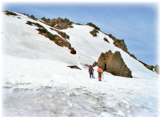
(写真6) 雪に埋もれる不動平避難小屋
